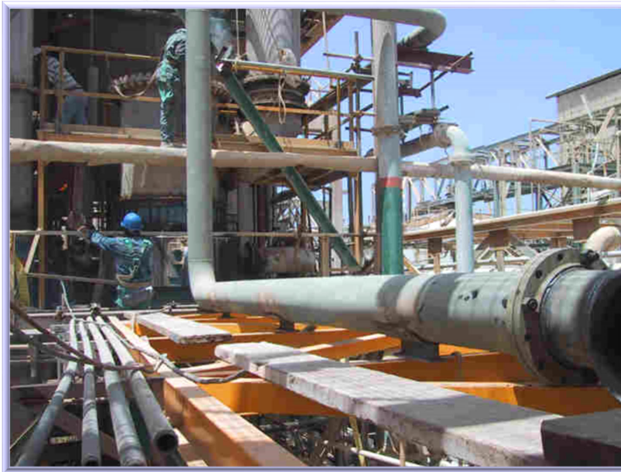
Motores asíncronos sistemas de bombeo de agua
